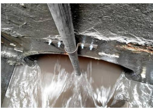
如果是管道内安装，可以不用断水，从管道顶部放支架下去固定。一般的管道在2000毫米以内，可以居中安装，传感器用支架固定在管道底部。支架要做成“L”型，传感器固定在“L”型支架的底部，深入管道内，传感器正对着水流方向。
